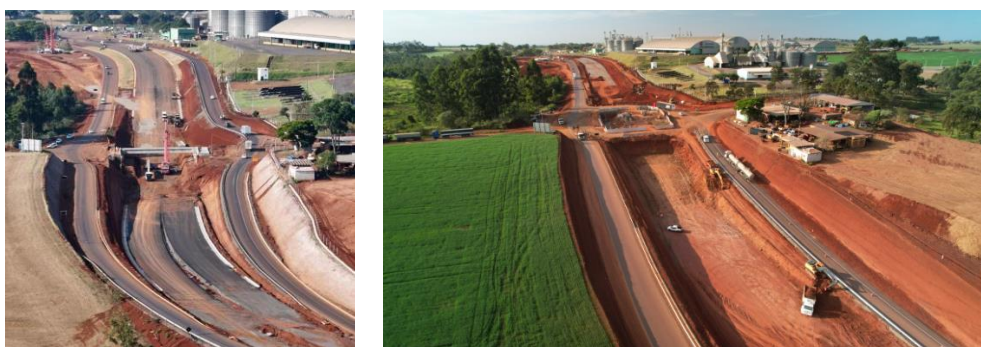
FIGURA 7 - FOTOS DA OBRA DUPLICAÇÃO E AMPLIAÇÃO DA CAPACIDADE E SEGURANÇA DA RODOVIA PR-445, NO TRECHO ENTRE MAUÁ DA SERRA (INTERSEÇÃO COM A BR-376) E O ACESSO A LERROVILLE
