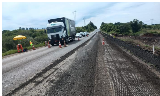
FIGURA 4 - FOTOS DA OBRA RESTAURAÇÃO EM WHITETOPPING NA RODOVIA PRC-280
