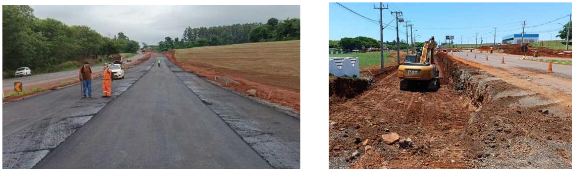
FIGURA 5 - FOTOS DA OBRA DE DUPLICAÇÃO E RESTAURAÇÃO DA RODOVIA PR-317
