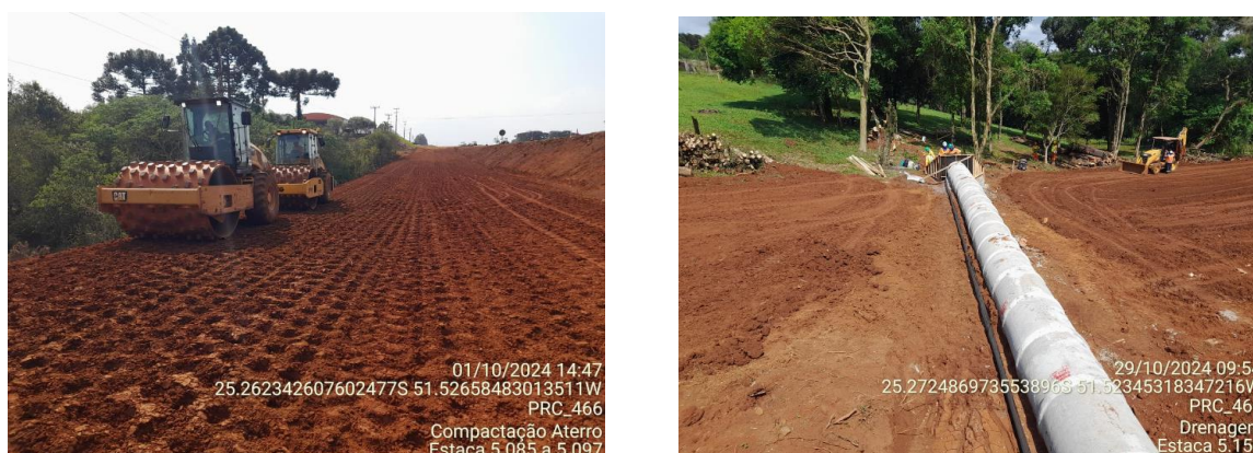
FIGURA 6 - FOTOS DA OBRA DE DUPLICAÇÃO E RESTAURAÇÃO DA RODOVIA PRC-466, NO TRECHO ENTRE PALMEIRINHA E GUARAPUAVA
