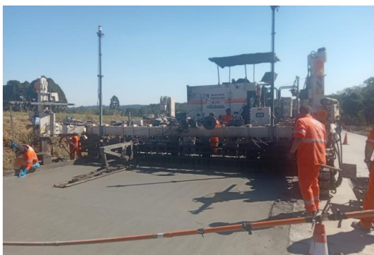
FIGURA 4 - FOTOS DA OBRA RESTAURAÇÃO EM WHITETOPPING NA RODOVIA PRC-280
