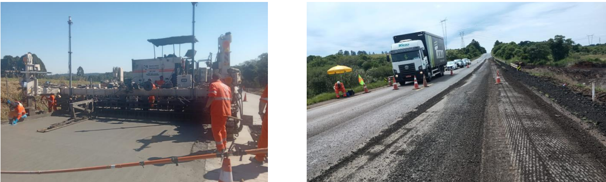
FIGURA X - FOTOS DA OBRA RESTAURAÇÃO EM WHITETOPPING NA RODOVIA PRC-280 – PARANÁ 2024
