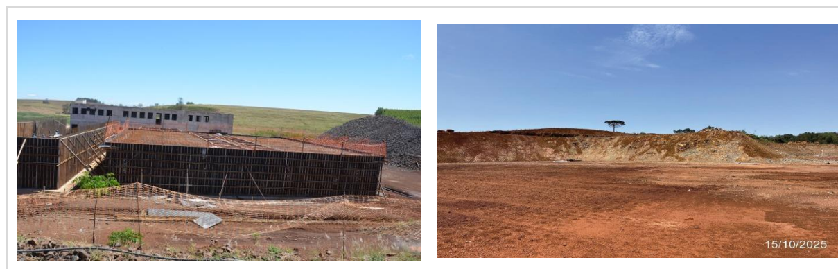
FIGURA 60 - OBRAS EM RIBEIRÃO DO PINHAL E LARANJEIRAS DO SUL - PARANÁ 2025
