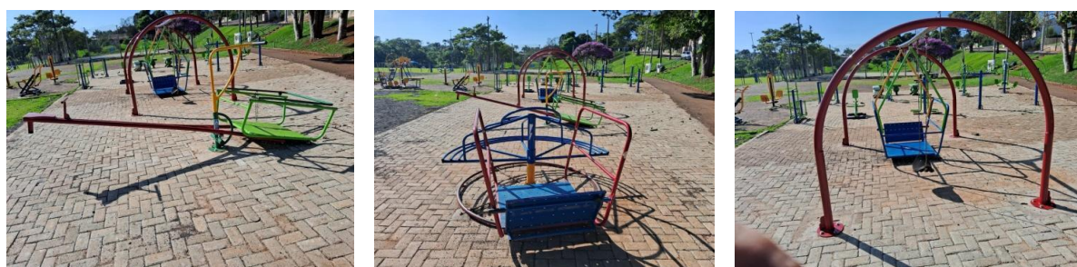
FIGURA 59 - INSTALAÇÃO, EM 2024, DE KIT DE BRINQUEDO ACESSÍVEL NO CENTRO SOCIAL URBANO DE TAMARANA
