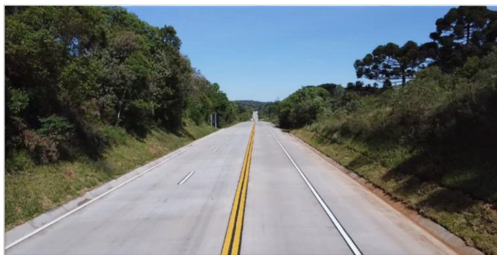
FIGURA 23 - RESTAURAÇÃO WHITETOPPING, TRECHO PALMAS E CLEVELÂNDIA, 2025
