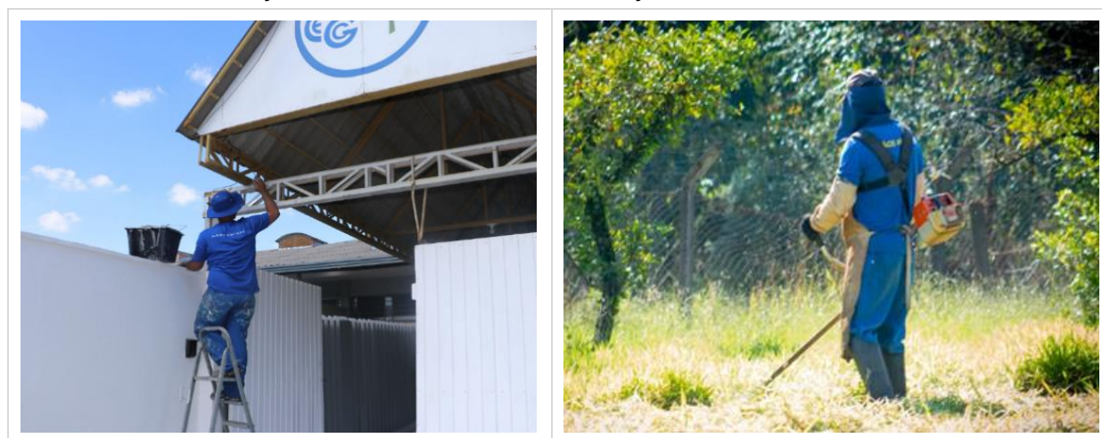
FIGURA 72 – MANUTENÇÃO DE PRÉDIOS ESCOLARES / ROÇADA
