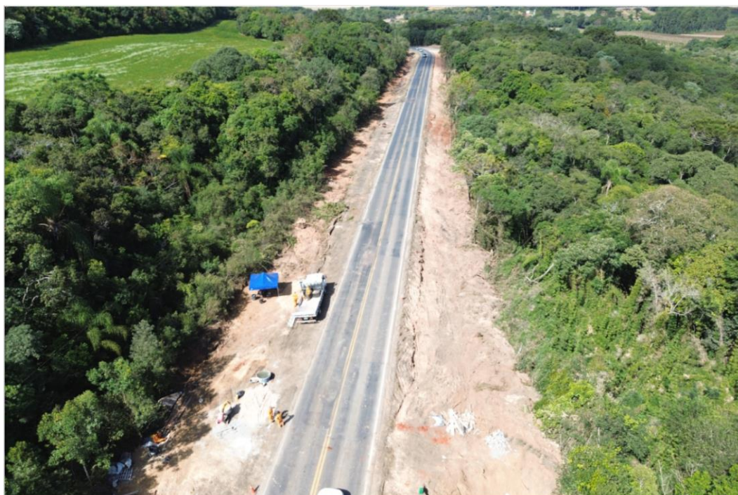
FIGURA 25 - DUPLICAÇÃO WHITETOPPING DA PR-151 ENTRE PONTA GROSSA E PALMEIRA, 2025
