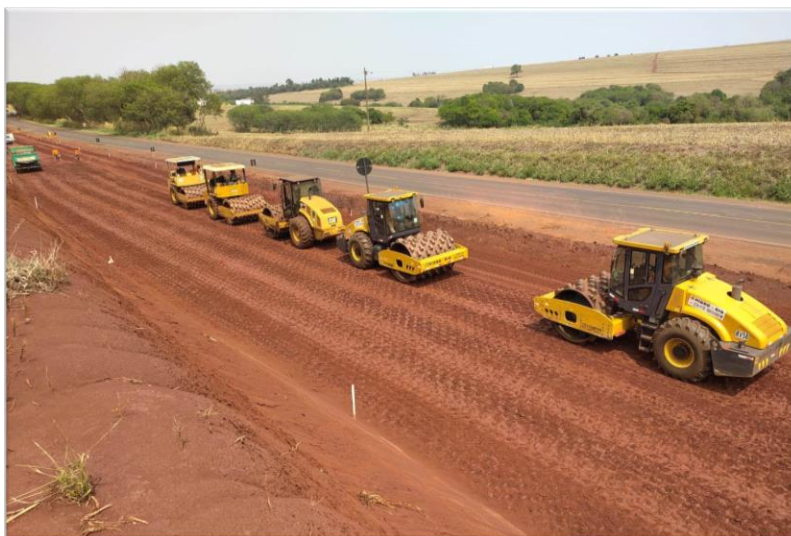
FIGURA 26 - DUPLICAÇÃO E RESTAURAÇÃO DA RODOVIA PR-317, 2025
