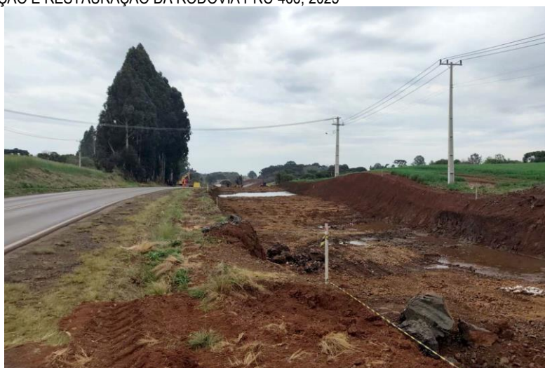
FIGURA 27 - DUPLICAÇÃO E RESTAURAÇÃO DA RODOVIA PRC-466, 2025
