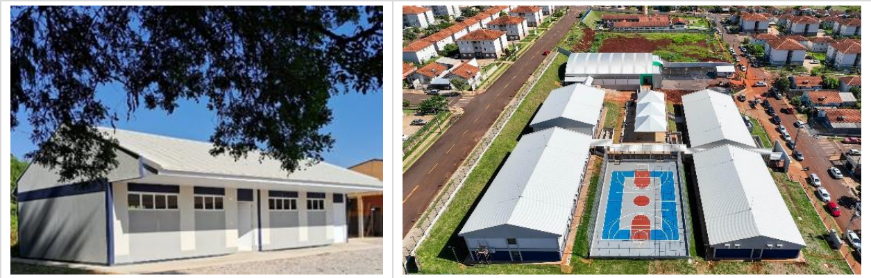
FIGURA 74 – CE ANDREIA NERES DOS SANTOS - CASCAVEL / SALAS DE AULA SISTEMA WOODFRAME
