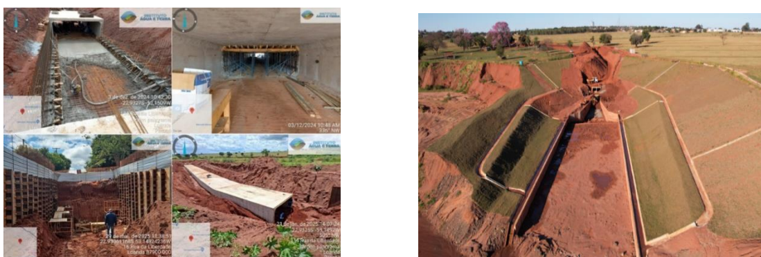
FIGURA 39 - EXECUÇÃO DO CANAL E DO DISSIPADOR
