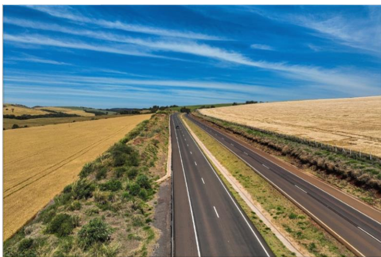
FIGURA 31 - DUPLICAÇÃO E AMPLIAÇÃO DA RODOVIA PRC-445, 2025
