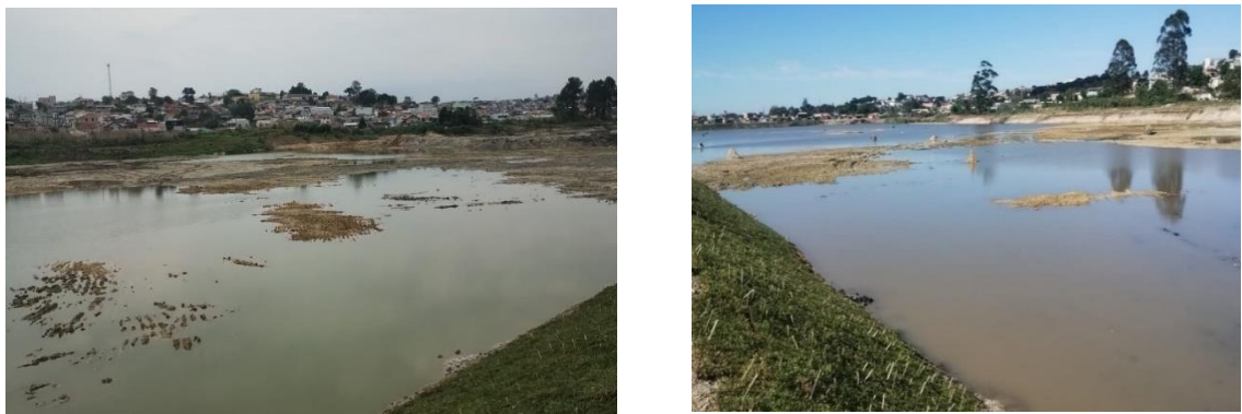
FIGURA 38 - ESCAVAÇÃO DA BACIA 0101 E BACIA 0102B
