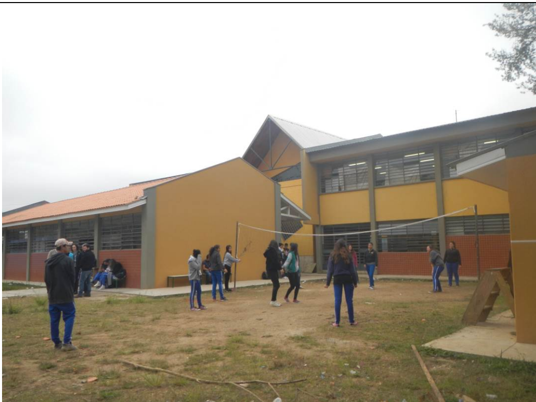
Fotografia nº 18 – Colégio Estadual Ambrósio Bini – obra de Reforço estrutural, Reparos e Melhorias por gestão centralizada - Município de Almirante Tamandaré – Data: 26/06/2015.
