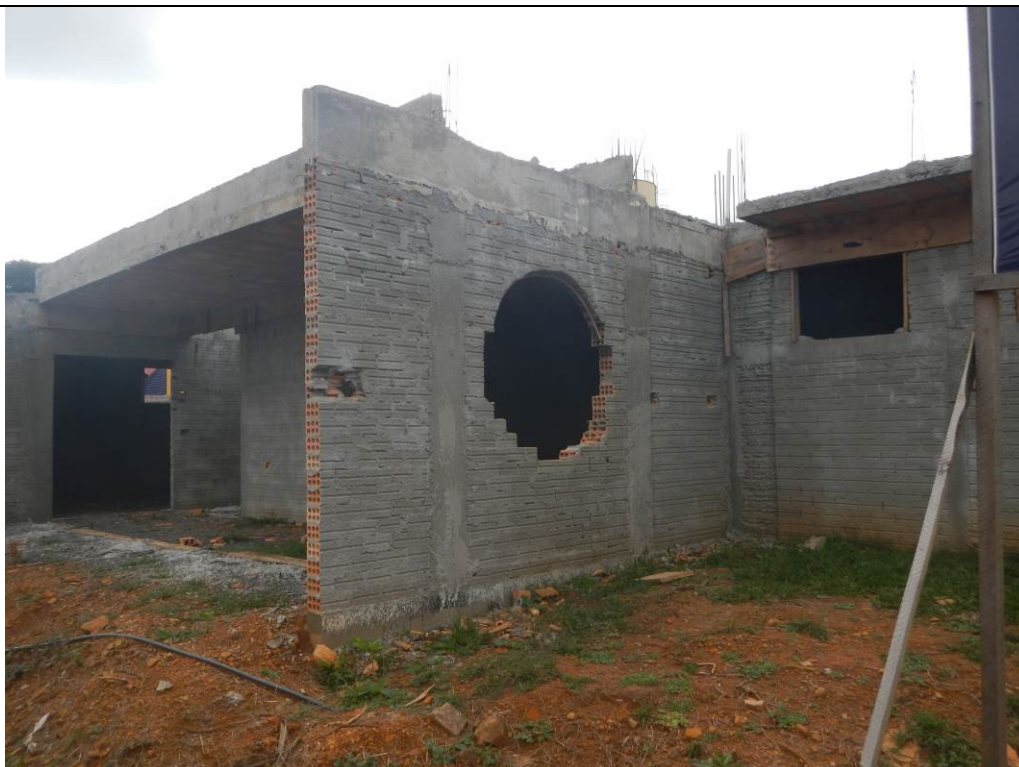
Fotografia nº 05 – Obra de Unidade de Saúde no Município de Bituruna que se encontrava paralisada na data da visita – Data: 29/04/2015.
