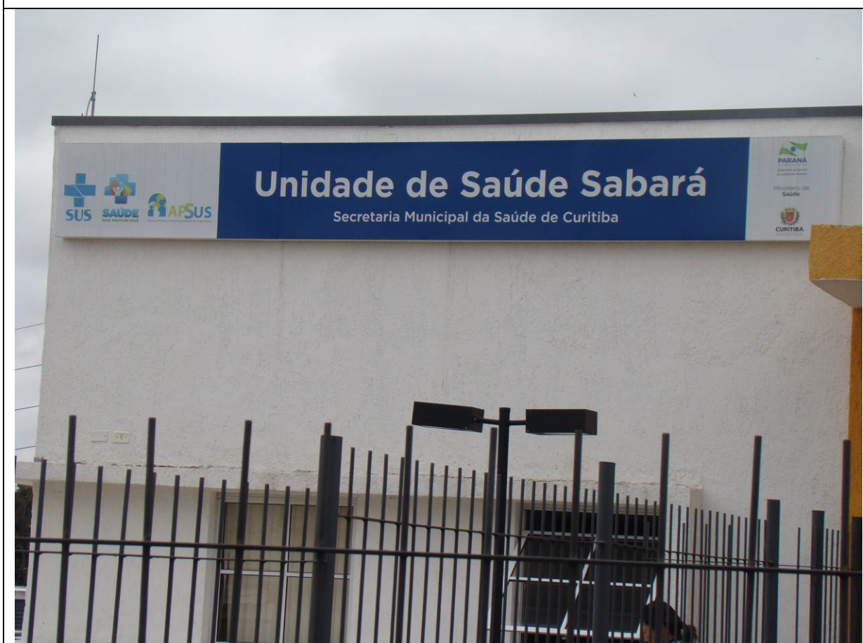
Fotografia nº 02 – Obra de reconstrução da Unidade de Saúde Sabará – Município de Curitiba. Data: 06/05/2015.
