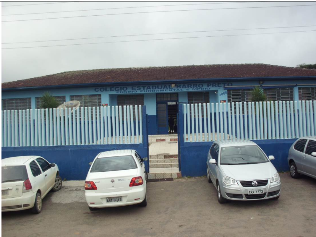
Fotografia nº 21 – Colégio Estadual Estadual Barro Preto – obra de Reparos por gestão descentralizada – Município de São José dos Pinhais – Data: 29/04/2015.
