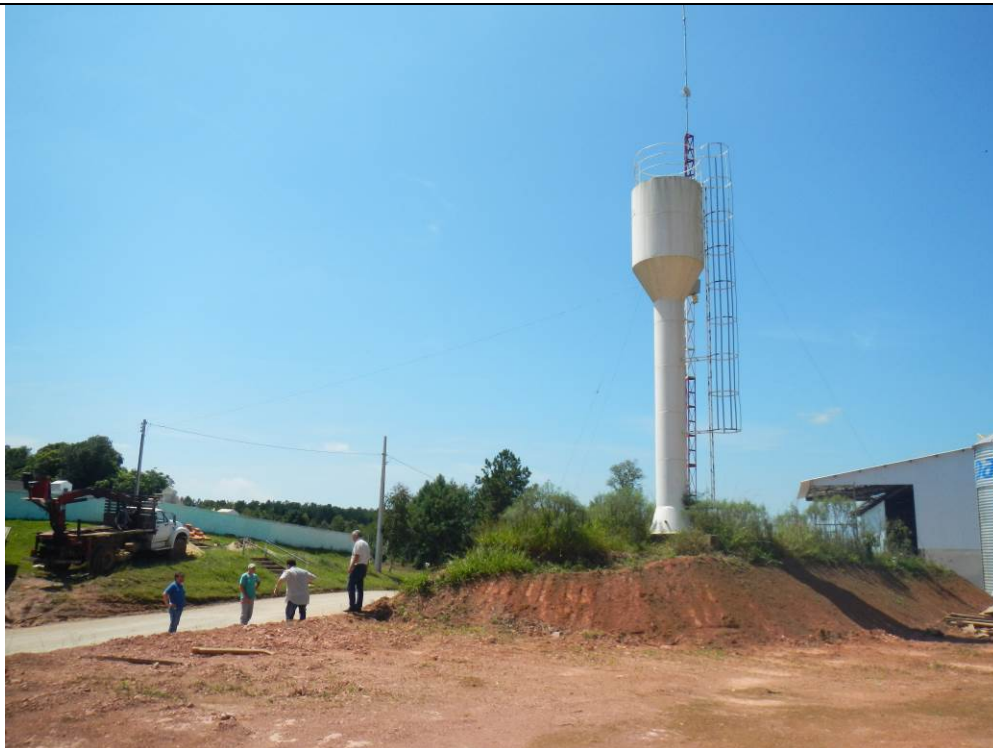
Fotografia nº 09 – Sistema de abastecimento de água – Localidade Faxinal dos Correias, Município da Lapa – Data: 04/03/2015.
