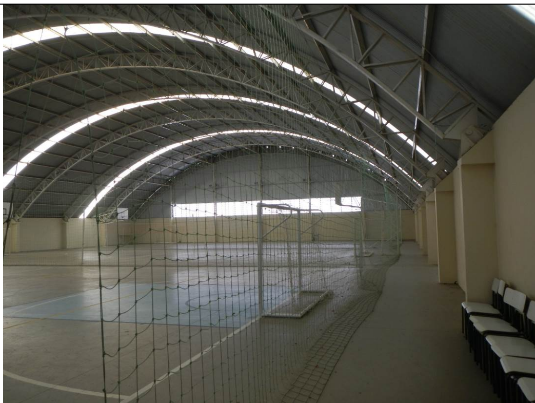
Fotografia nº 17 – Colégio Estadual Pilar Maturana – obra de Reparos e Melhorias por gestão centralizada – Município de Curitiba – Data: 26/06/2015.
