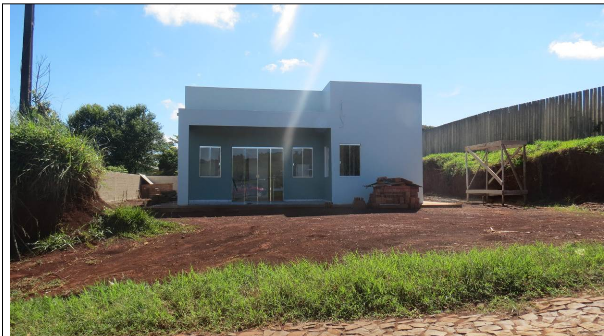
Fotografia nº 01 – Obra de construção da Unidade de Saúde da Família no Distrito de Guampará – Município de Marquinho – Data: 12/05/2015.
