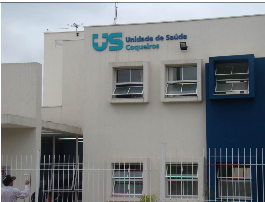
Fotografia nº 03 – Obra de construção da Unidade de Saúde Coqueiros - Curitiba. Data: 06/05/2015.
