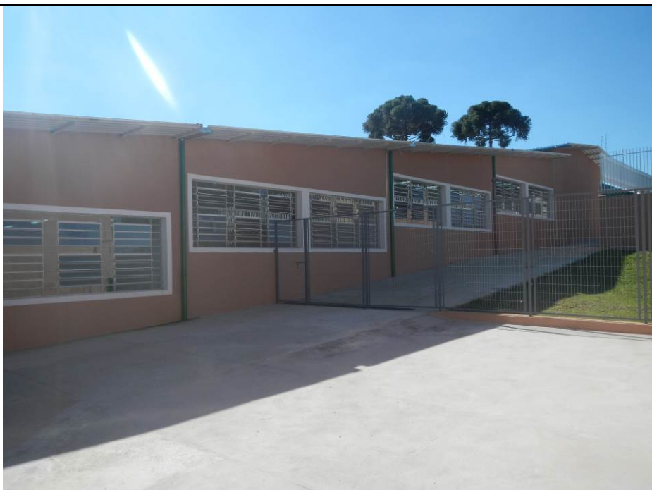
Fotografia nº 15 – Colégio Estadual Yvone Pimentel – obra de Ampliação e Reparos por gestão centralizada – Município de Curitiba – Data: 25/06/2015.
