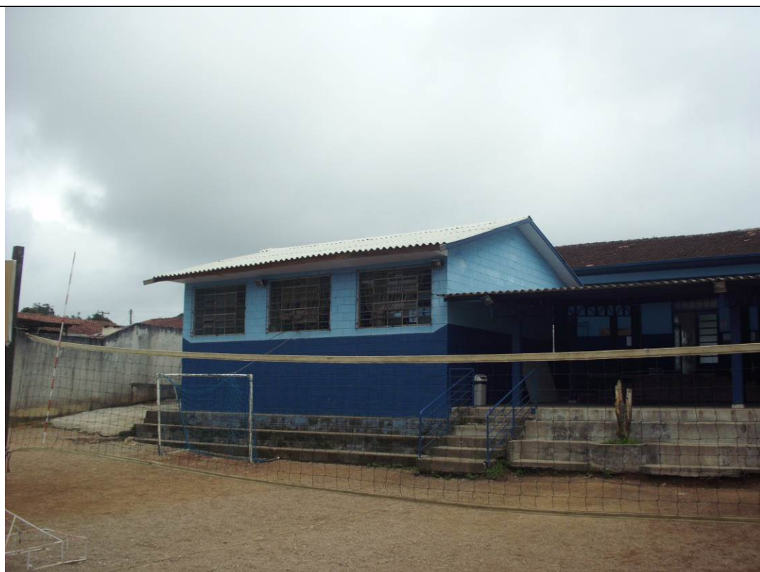
Fotografia nº 22 – Colégio Estadual Estadual Barro Preto – obra de Reparos por gestão descentralizada – Município de São José dos Pinhais – Data: 29/04/2015.
