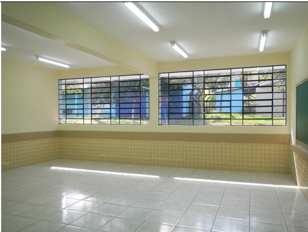
Fotografia nº 20 – Colégio Estadual Professora Dirce Celestino do Amaral – obra de Ampliação por gestão centralizada – Município de Curitiba – Data: 29/04/2015.
