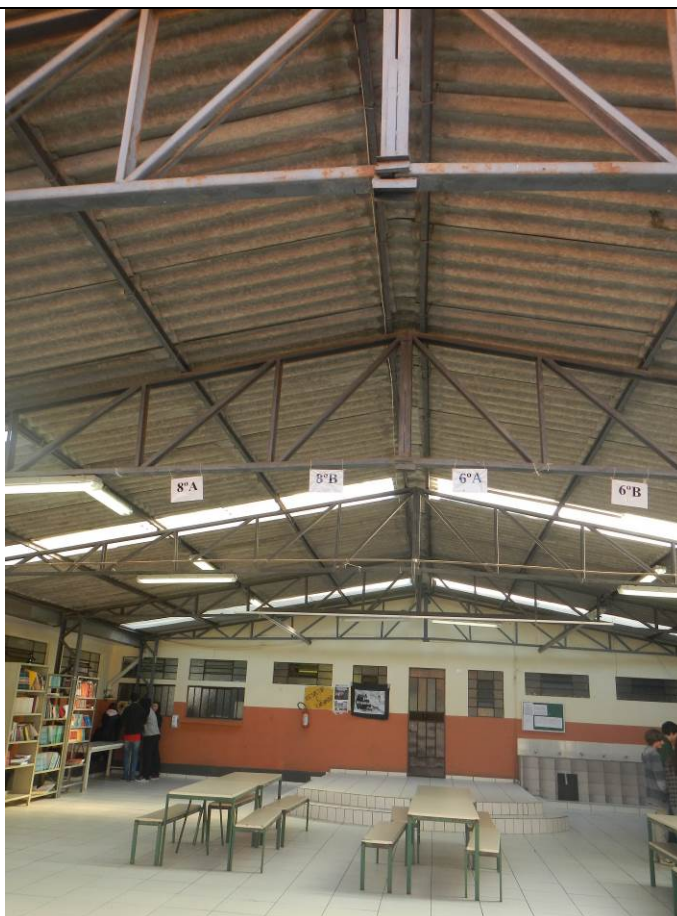
Fotografia nº 16 – Colégio Estadual Amâncio Moro – obra de Reparos e Melhorias por gestão centralizada – Município de Curitiba – Data: 26/06/2015.
