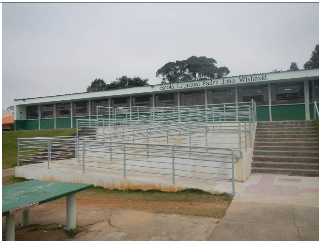
Fotografia nº 19 – Escola Estadual Padre João Wislinski – obra de Ampliação por gestão centralizada – Município de Curitiba – Data: 24/06/2015.
